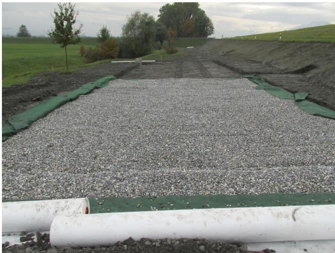
Bau Interventionspiste Nord, Diepoldsau, eingebaute Drainschicht (Okt. 2020)
