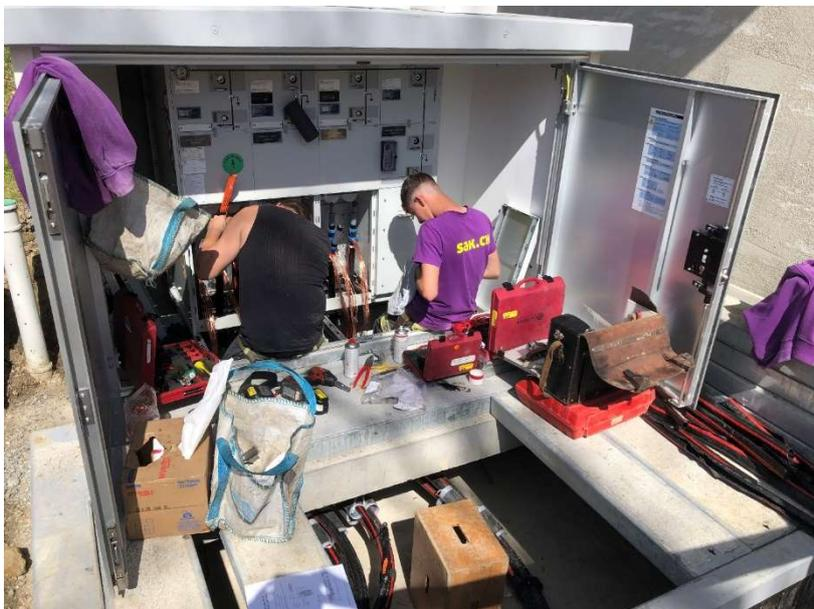
Neubau TS im Steinbruchareal durch die SAK aufgrund von neuer 20 kV Leitung zwischen Steinbruch Oberbüchel und der Schaltkabine Lienz
