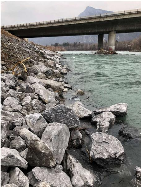
Sanierung Uferschutz oberhalb der Autobahnbrücke in Bad Ragaz
