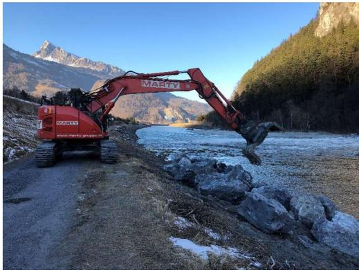
Die Überwachung der Ellhornschwelle zeigte, dass nach einigen Hochwasserereignissen kleinere Unterhaltsmassnahmen an der Blockrampe erforderlich wurden. Zusammen mit dem Büro «Hunziker, Zarn & Partner» wurde beschlossen, dass die Schwelle mit einigen Wasserbausteinen ergänzt werden musste. Die Unterhaltsarbeiten wurde vom Rheinunternehmen, Werkhof Trübbach, ausgeführt.
