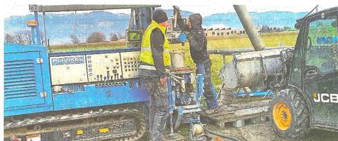
Fachleute führen im Rheinvorland in Kriessern die für den Dekolmationsversuch nötigen Bohrungen durch.
